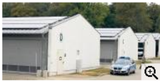
Hier wird Strom und Sicherheit produziert: Die neuen Photovoltaikanlagen auf Polizeigebäuden in Eiche. Foto: Manfred Thomas
